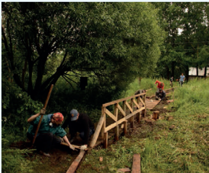
Сооружение деревянных мостков на планируемом экологическом маршруте в дендрарии.
